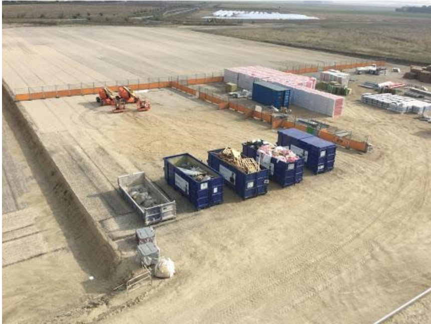
Figure 53 : Bennes de tri des déchets sur un chantier FM France
